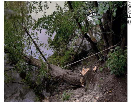
Auf einer Pilotstrecke wird der Eschenahorn am Ufer entfernt und mit Hanfseilen gesichert. Dadurch erhöht sich der Anteil an Totholz im Wasser.
