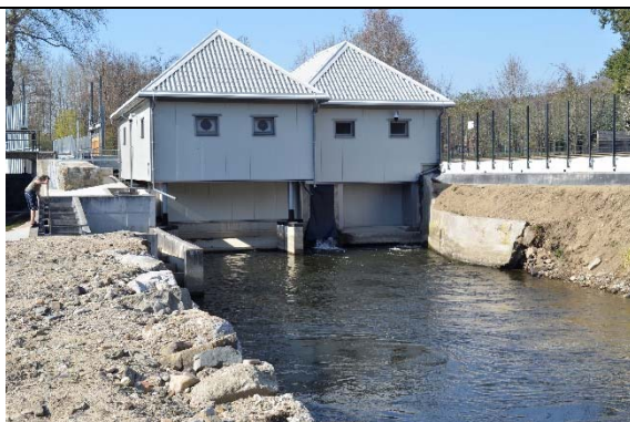
Abbildung 40: Turbinenauslauf mit Einstieg FAH (links)
