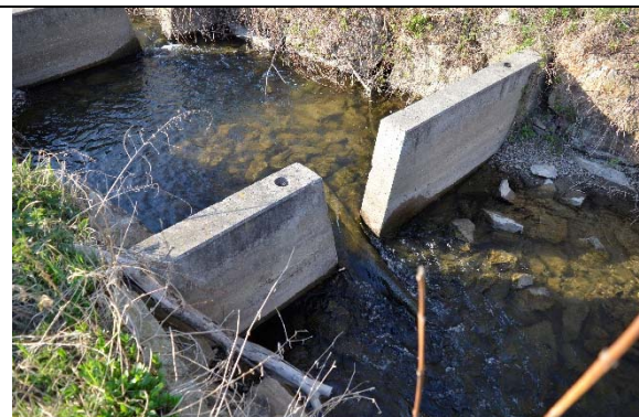
Abbildung 20: Sehr geringe hydraulische Tiefe bei Schlitzten
