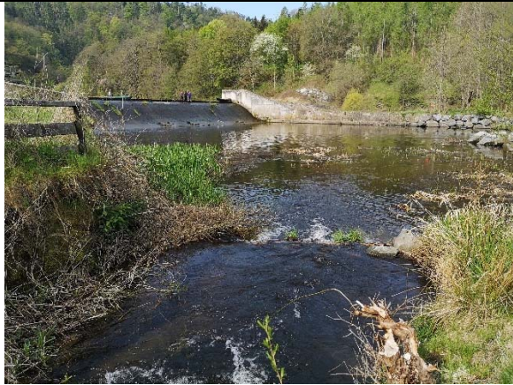
Abbildung 111: Mündung der FAH rechtsufrig im Wehrunterwasser
