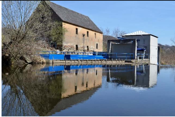
Abbildung 59: Beginn Triebwasserkanal
