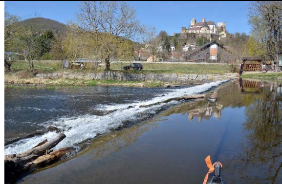
Abbildung 75: Wehr mit Überwasser
