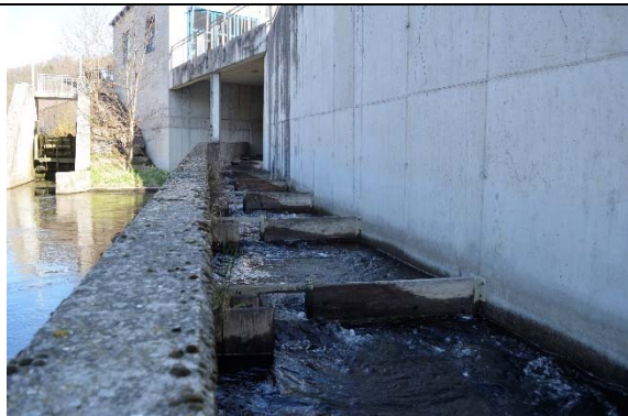
Abbildung 96: Schlitzpass im Einstiegsbereich
