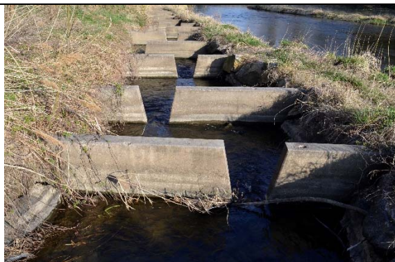
Abbildung 19: Technischer Beckenpass im Überblick
