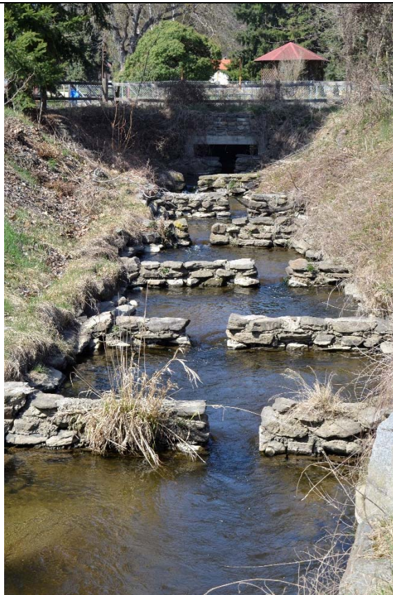
Abbildung 46: Technischer Beckenpass mit Ausstieg (oben)
