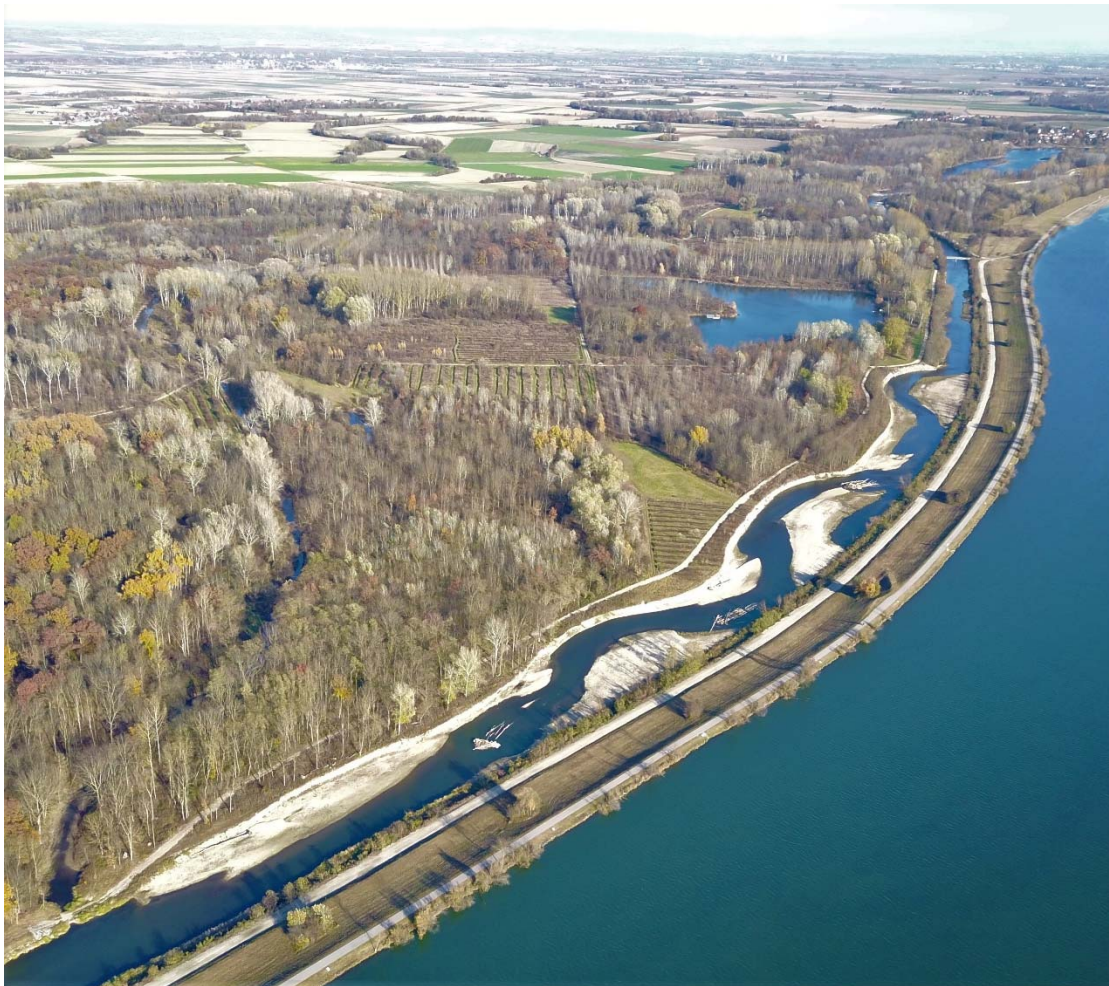
Abbildung 4: Krems-Kamp-Umleitungsgerinne im Bereich der ehemaligen Sohlstufe 11 nach Umbau 2021
