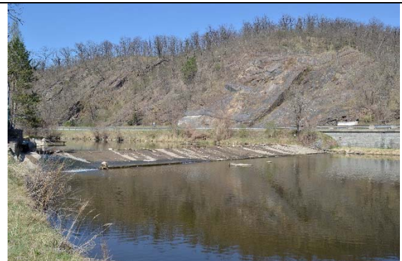
Abbildung 47: Wehr mit Wehrkolk
