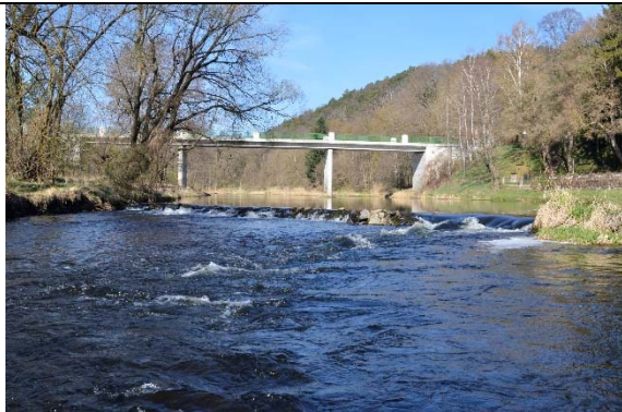
Abbildung 109: Sohlschwelle Straßenbrücke flussauf Rosenberg (rechtsufrig)
