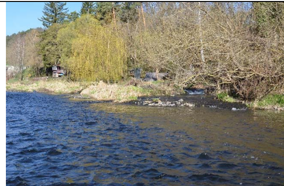
Abbildung 110: Sohlschwelle Straßenbrücke flussauf Rosenberg (linksufrig)
