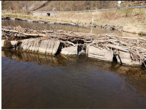
Abbildung 51: Verklausung im Bereich der Schlitze
