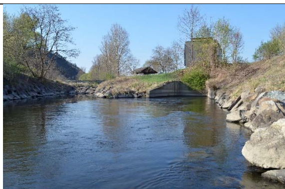
Abbildung 33: Turbinenauslauf (linksufrig)
