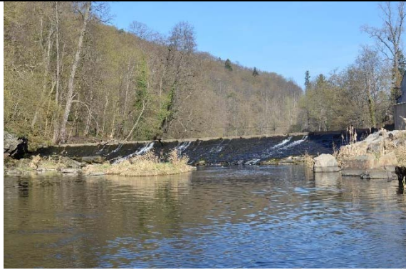
Abbildung 106: Wehr mit Wehrklappe
