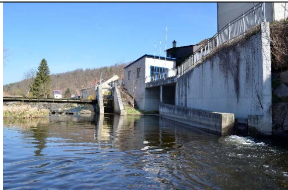
Abbildung 98: Turbinenauslauf mit Einstieg FAH
