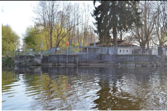
Abbildung 15: Beginn Triebwasserkanal am rechten Ufer
