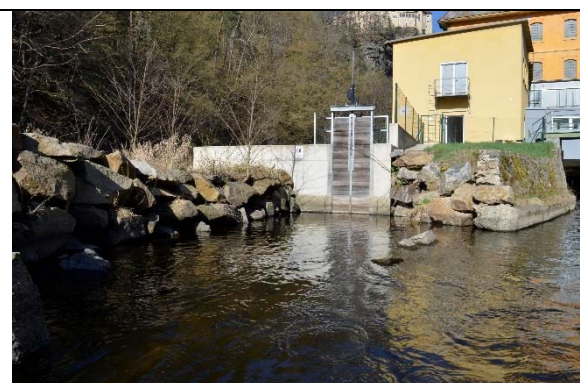
Abbildung 105: Einstieg FAH im Unterwasser mit Bucht
