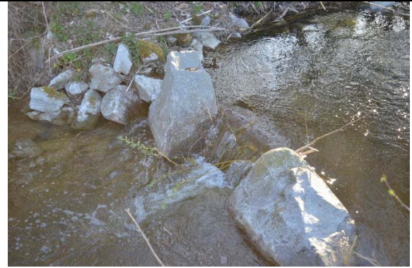
Abbildung 8: Verklausung im oberen FAH Bereich
