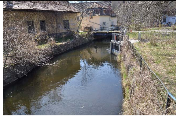
Abbildung 68: Ausstieg FAH in Triebwasserkanal
