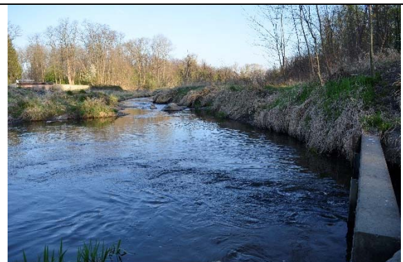
Abbildung 14: Einstieg FAH mit Restwasserstrecke
