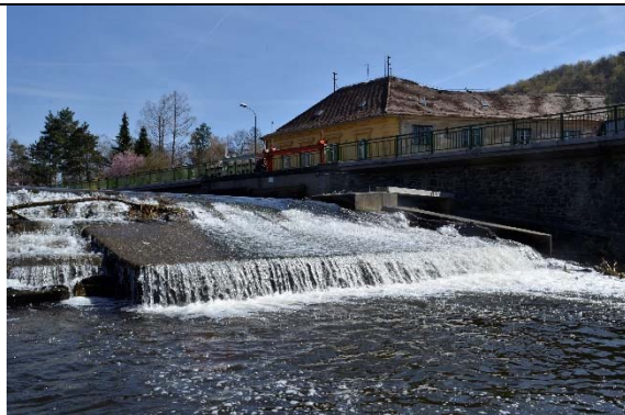
Abbildung 76: Wehr mit Turbineneinlass oberhalb
