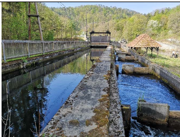
Abbildung 113: Oberwasserkanal und oberer Teil der FAH in Form eines Vertikal Slots
