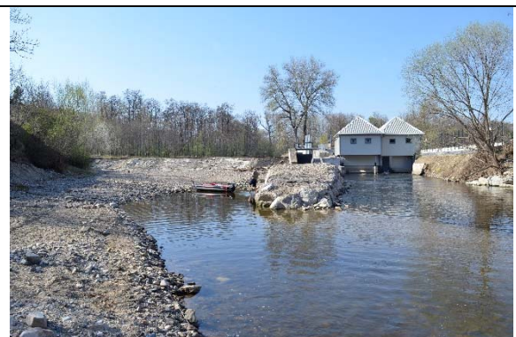
Abbildung 41: Wehr (ohne Kolk) und Kraftwerksanlage im Überblick
