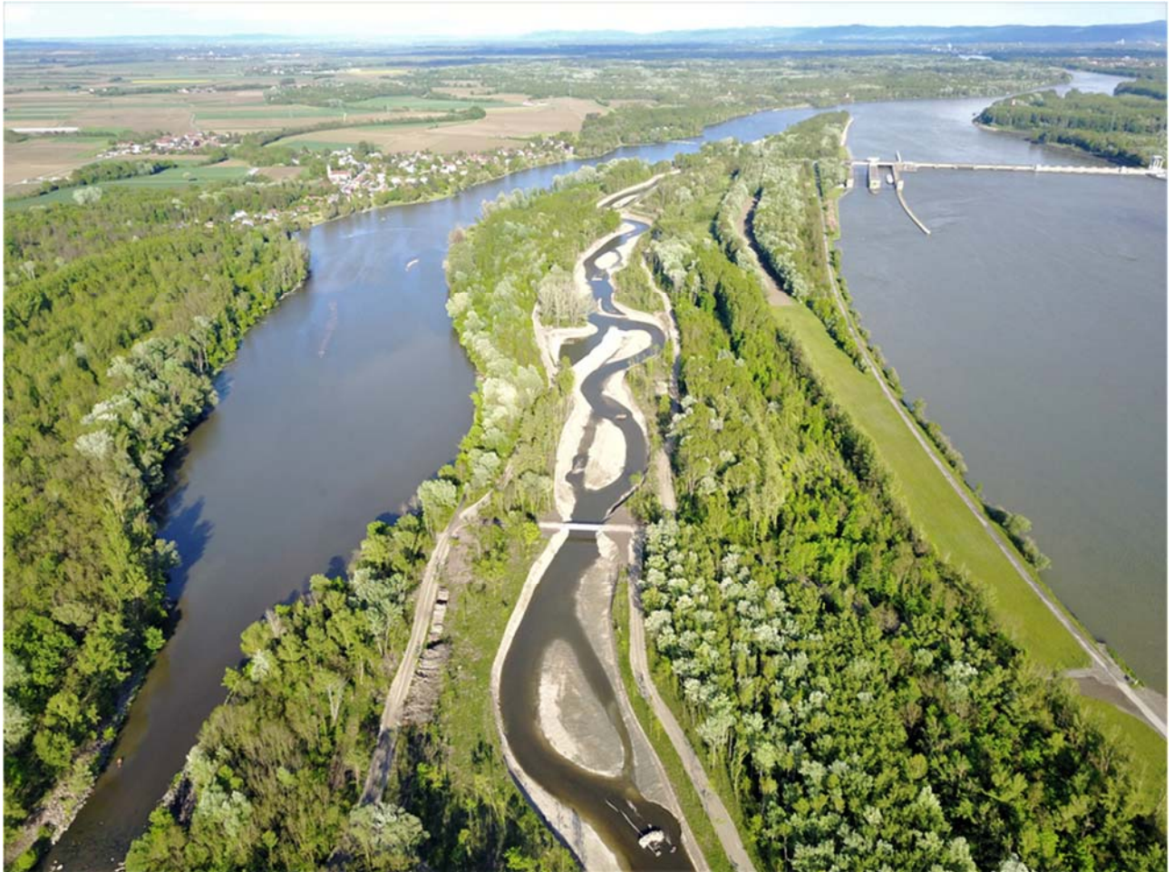
Abbildung 3: Neuer Nebenarm Altenwörth, Blickrichtung flussab
