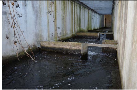
Abbildung 95: Schlitzpass im Ausstiegsbereich
