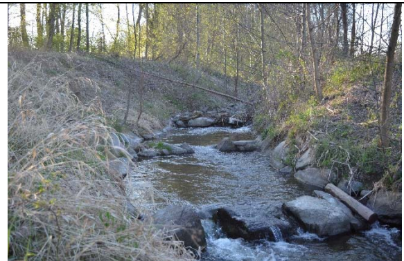
Abbildung 10: Beckenpass mit Verklausung
