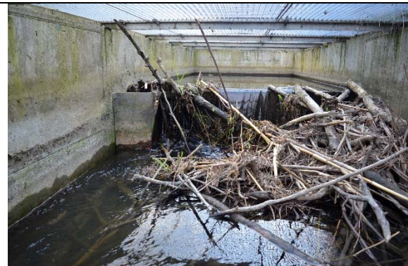
Abbildung 18: Extrem verklauster oberster Schlitz der FAH
