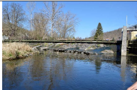
Abbildung 99: Wehr mit Wehrklappe
