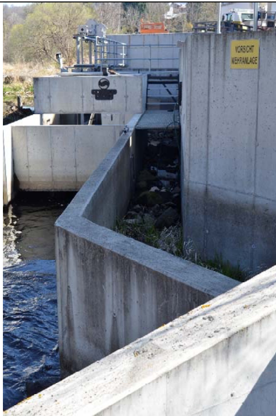
Abbildung 87: Trockengefallener oberer Teil der FAH
