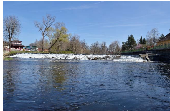
Abbildung 77: Festes Wehr (links) und Klappwehr (rechts)
