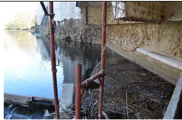
Abbildung 101: Starke Verklausung im Bereich des Ausstiegs
