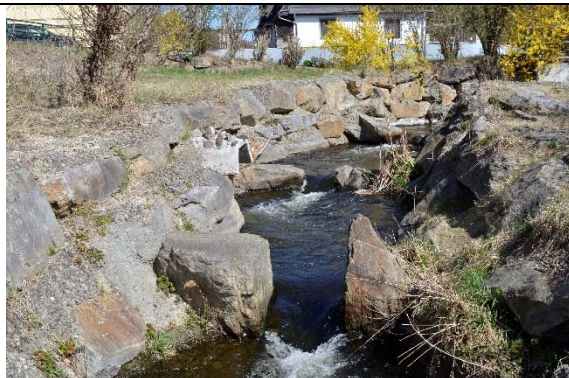
Abbildung 81: Steiler Beckenpass
