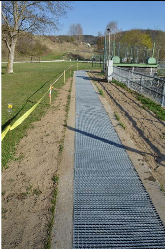
Abbildung 27: Vergitterter oberer Teil der FAH
