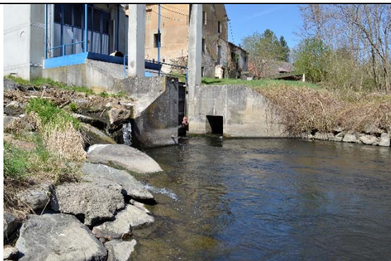
Abbildung 63: Turbinenauslauf mit Einstieg FAH
