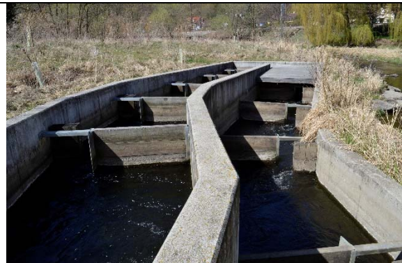
Abbildung 70: Schlitzpass teilweise abgedeckt
