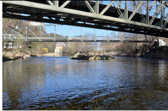
Abbildung 107: Kiesfurt mit Insel im Unterwasser
