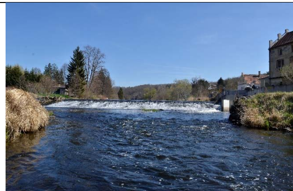
Abbildung 92: Wehr mit Überwasser trotz Niederwasser
