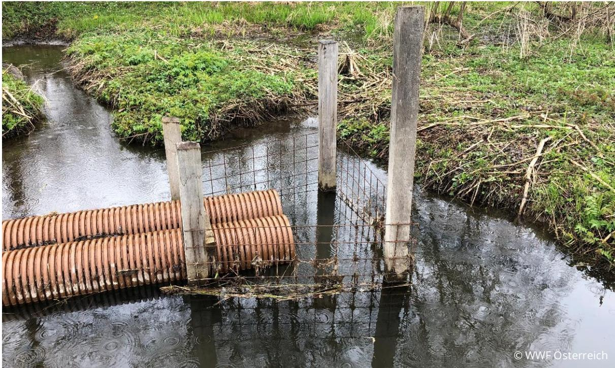
Abbildung 22: Eine Dammdrainage zur Absenkung des Wasserspiegels
